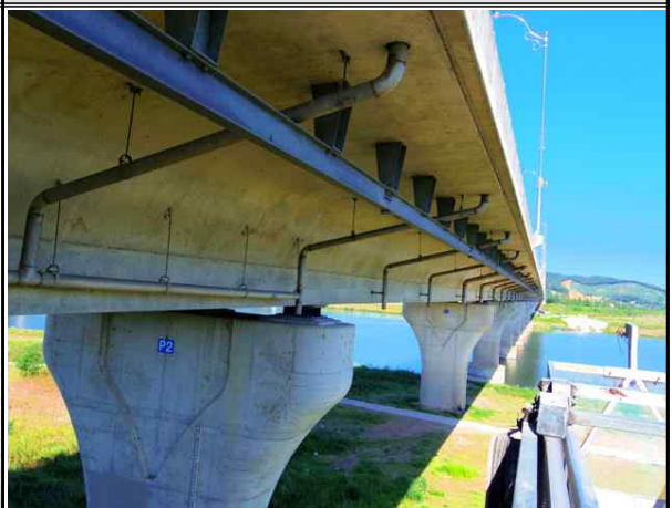
거더 외부 전경
