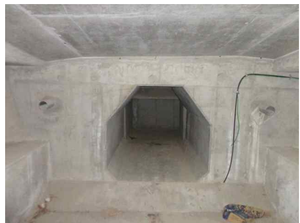
주형 내부전경 (지점부 교각)
