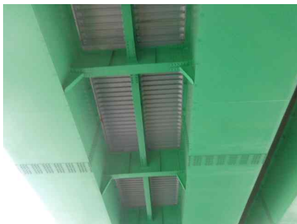
가로보 및 스트링거 전경
